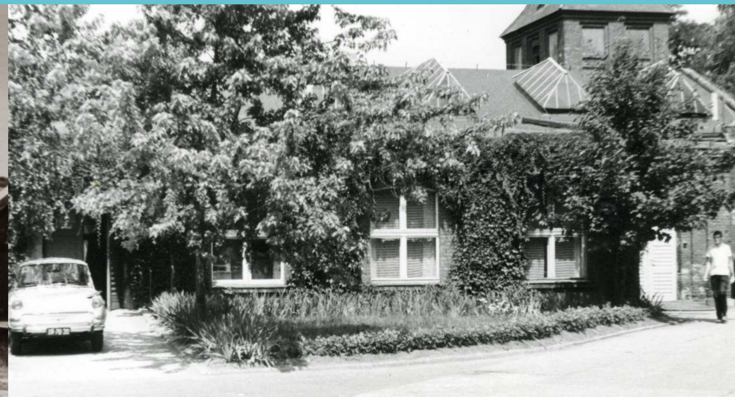
Budynek Wydziału Włókienniczego rozebrany w latach 2001-2003. Do dziś zachowała się tylko wieża
