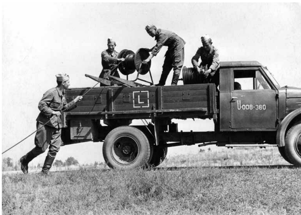
Fot.49 Ćwiczenia „budowa linii telefonicznej kablem ciężkim”. Rok 1951
